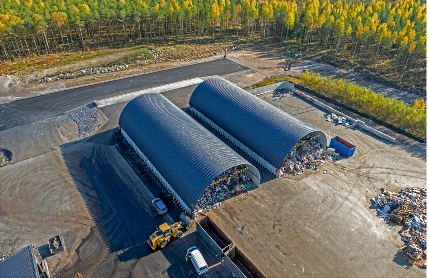
Kaarihallien sisäkorkeus mahdollistaa niiden sisällä työskentelyn pyöräkuormaajalla. Kenttä, johon jätteen varastohallit rakennettiin jää lastausaluetta yleemmäksi. Lastausalue, johon rekka ajaa noutamaan jätettä, sijoittuu kuvan yläosaan.
