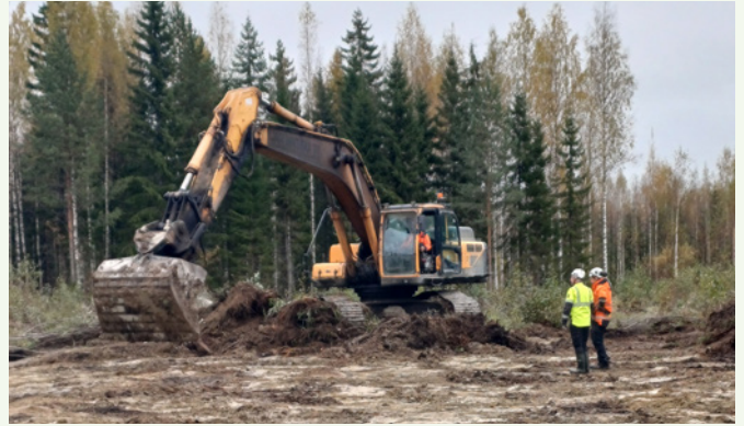
Hankasalmen lajitteluaseman rakentaminen käynnistyi lokakuussa 2024.
