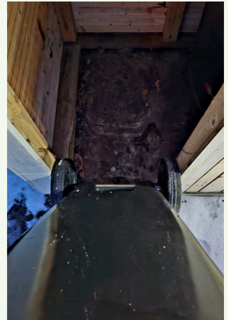
Jätekatoksen oviaukko tulisi mitoittaa niin, että jäteastia ei ota kiinni oviaukon reunoihin.
