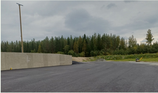
Pihtiputaan lajitteluasema asfaltoinnin jälkeen odottamassa lavoja, kontteja ja opasteita
